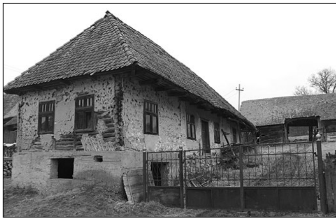
A központ épületegyüttese felújítás előtt...
