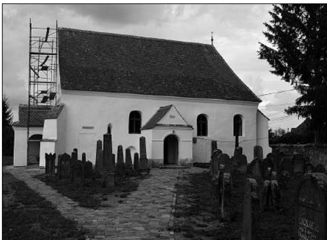
Befejezés előtt a templom külső felújítási munkálatai (2017)
